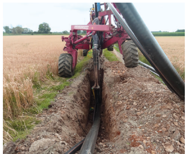
Abb. 27: Pflugverlegung
