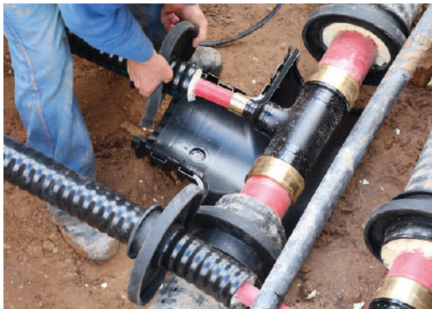
Abb. 4: Montage HeatClick Muffe im Bestand (Muffendichtgummi)
