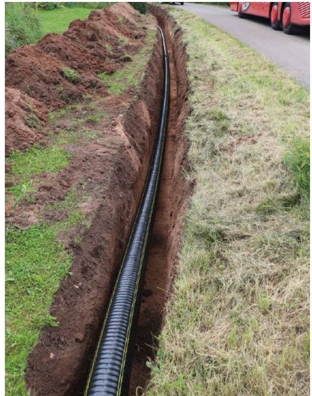
Abb. 2: Verlegung in der Praxis
