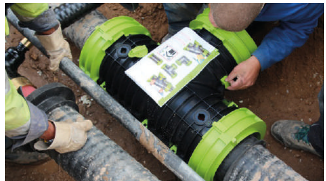
Abb. 5: Montage HeatClick Muffe im Bestand (Einsteckclip)
