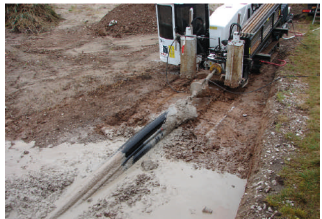
Abb. 29: Spülbohrgerät mit Rohren in der Startgrube
