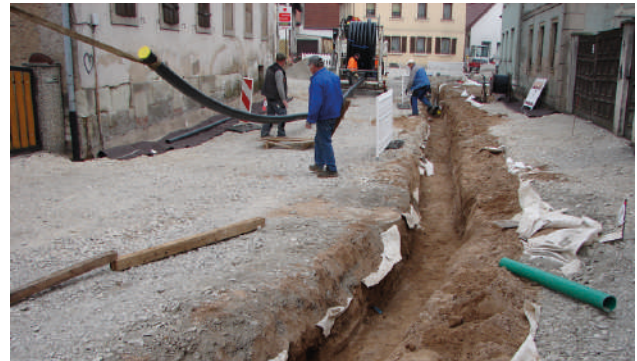
Abb. 30: Offener Rohrgraben und Abwickelvorrichtung
