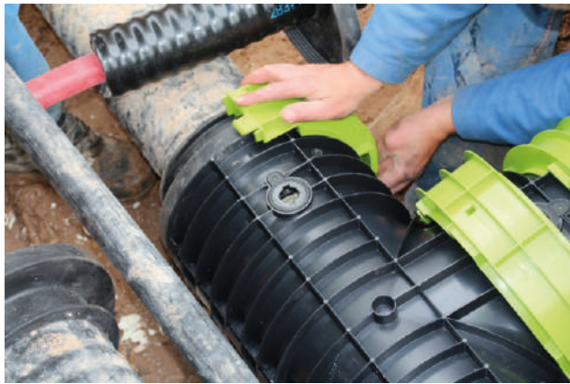
Abb. 3: Montage HeatClick Muffe im Bestand (Verschlussring)
